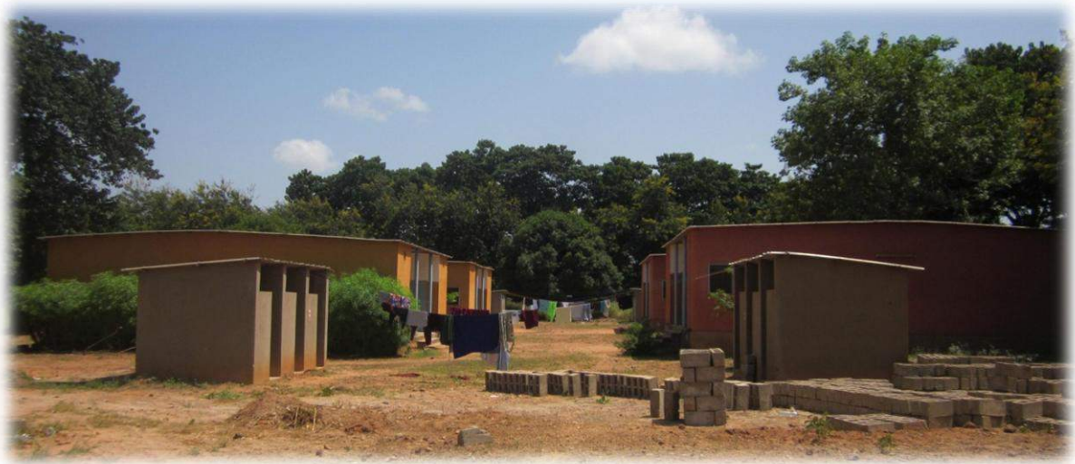
Die vier Schlafhäuser, der Mädchen, mit den Toiletten im Vordergrund.
